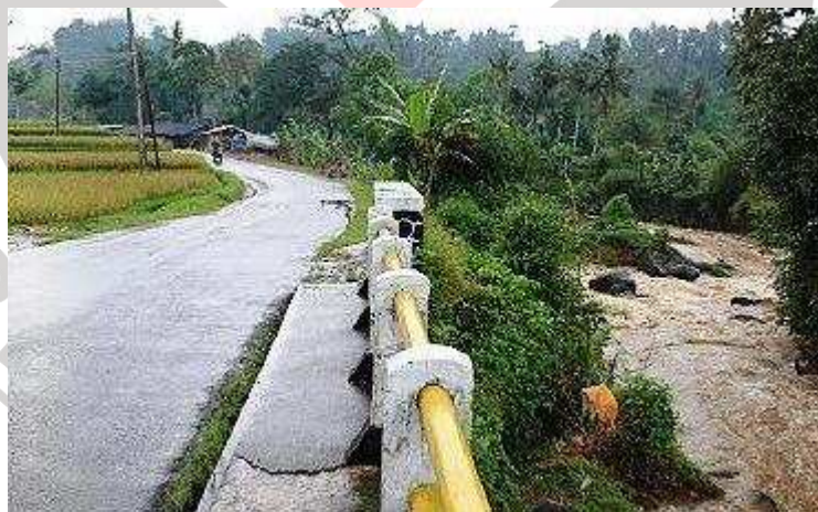
Gambar 4.10 Akses Jalan Menuju Desa Wanayasa
