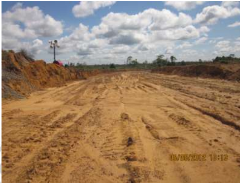
Gambar 3.1 jalur hauling km 02 arah jetty
