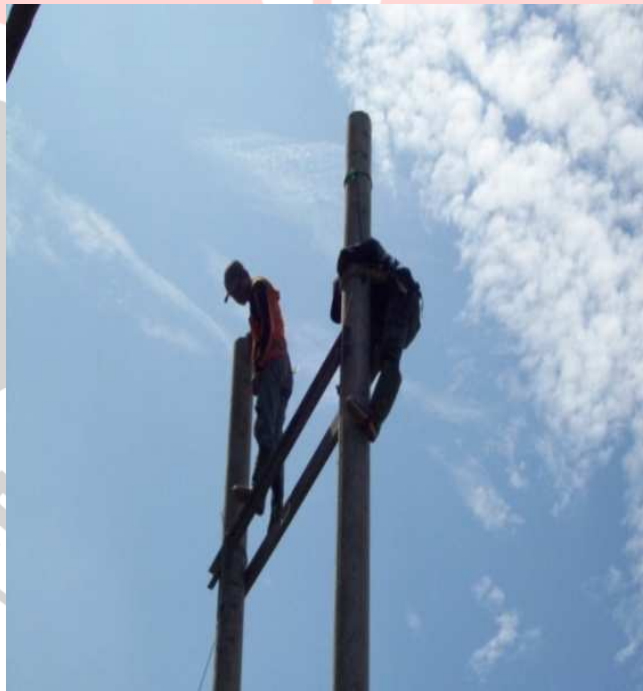
Gambar 3.2. Pemasangan Rangka Gardu Portal
