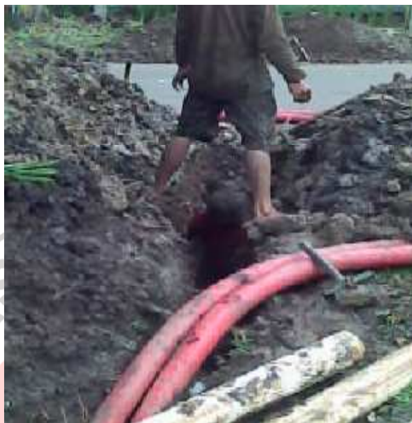
Gambar 3.5. Pemasangan Kabel TM XLPE 3 x 240 sqmm
