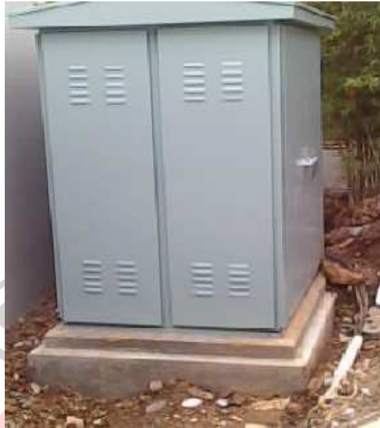
Gambar 3.4. Pemasangan Panel Cubickle
