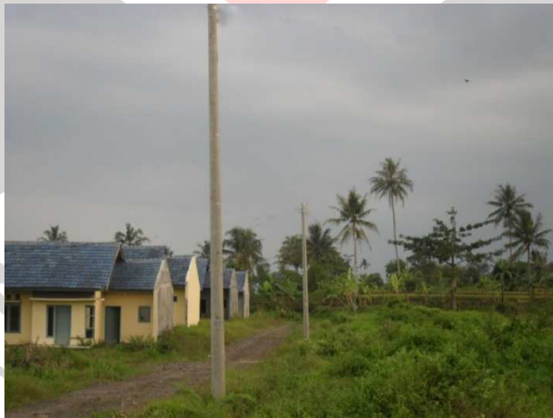
Gambar 3.3. Tiang 202 dan 203 Sebelum Terpasang Jaringan Listrik.
