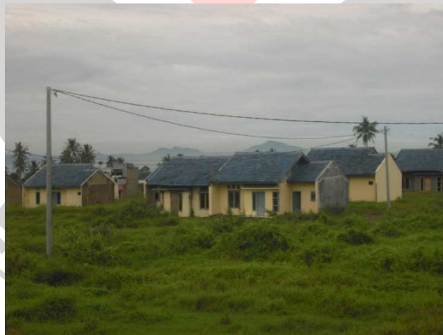
Gambar 3.5. Tiang 202 dan 203 Setelah Terpasang Jaringan Listrik
