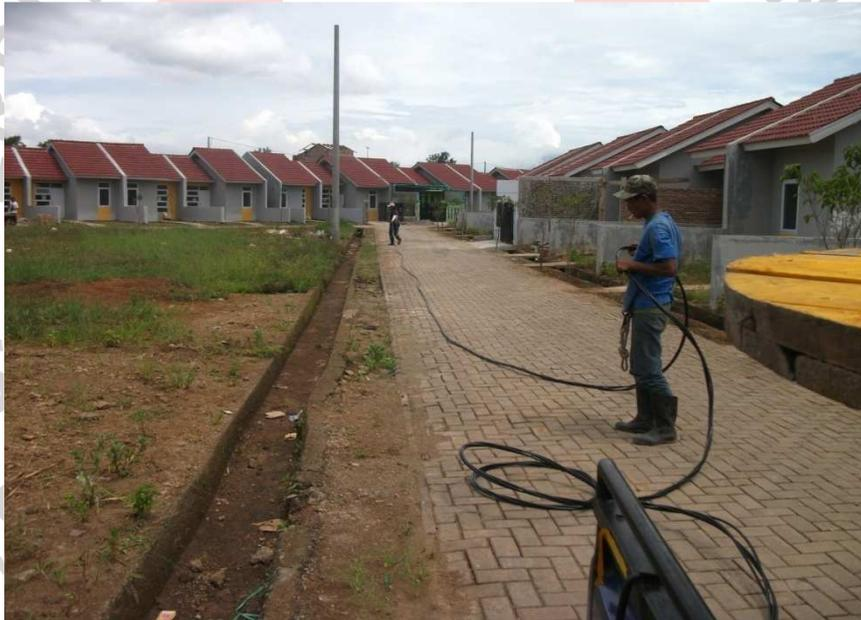
Gambar 3.1 Tiang posisi awal ( 1B ) kabel TIC yang di gelar untuk persiapan pemasangan jaringan listrik
