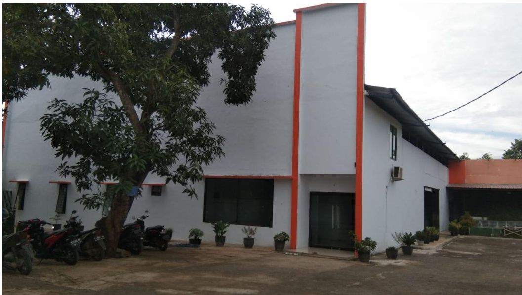
Gambar 3. 2 PT. Chakra Tunggal Elektrindo
