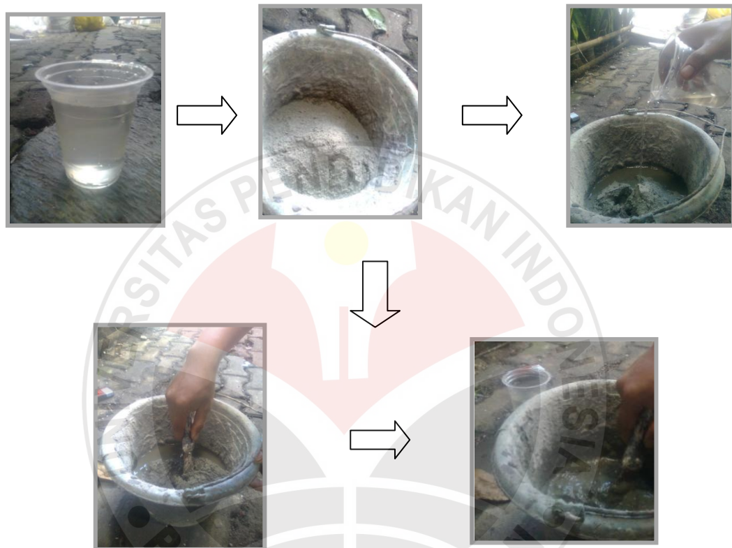
Gambar 3.22 Pengolahan Semen dengan Pencampuran Air Sumber : Dokumentasi Pribadi
