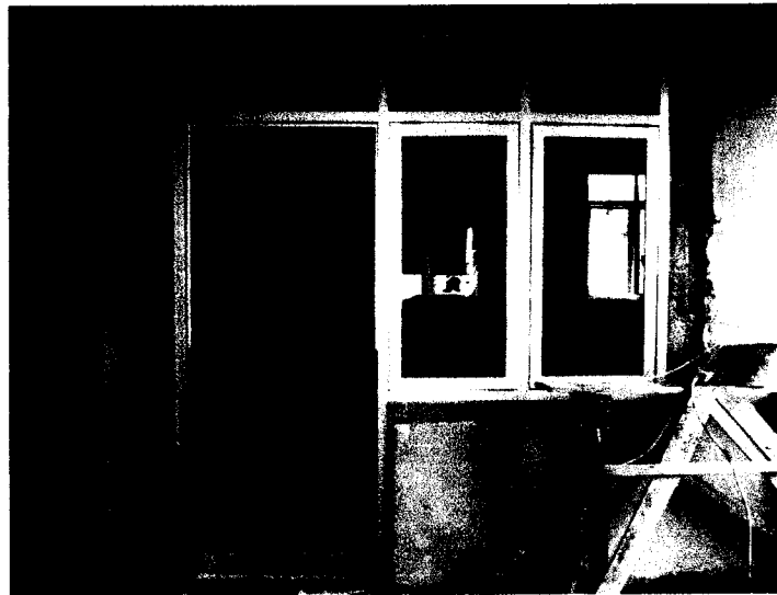
Gambar 3.9 Pintu dan jendela menggunakan alumunium
