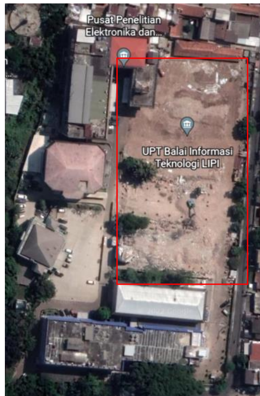
Gambar 3.5 Lokasi Proyek Pembangunan Gedung Infrastruktur BASICS
