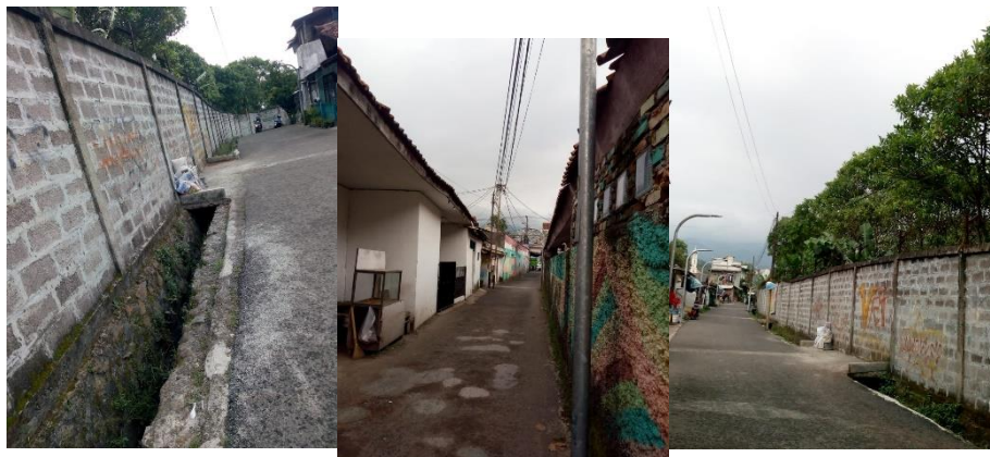
Gambar 3 17. Utilitas pada Tapak Sumber: dokumentasi pribadi
