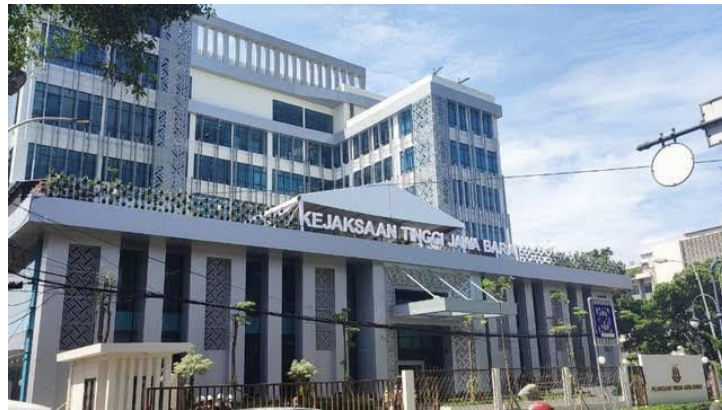
Gambar 3. 1 Gedung Kantor Pemerintah / FKPD Jawa Barat 2022
