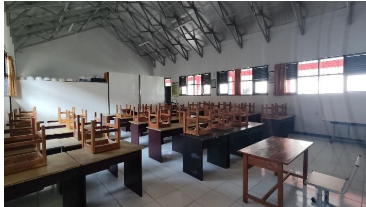
Gambar 3.4 Kondisi Ruang Lab. Gambar 1 SMKN 9 Garut Sumber: Dokumentasi Peneliti, 2022
