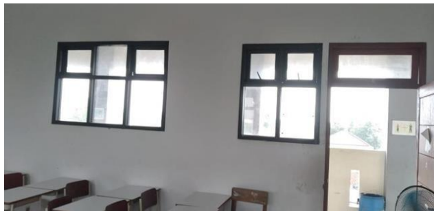
Gambar 4.9 Tampak Samping Awal Dinding Kelas
