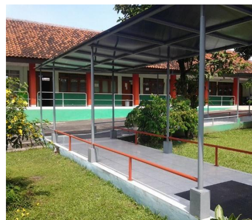
Gambar 3. 4 Gedung SLB D YPAC Bandung
