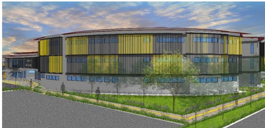
Gambar 5.10 Tampilan Fasade Bangunan Sumber: Dokumentasi Pribadi, 2018
