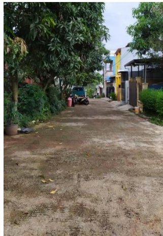
Gambar 0.12 Kondisi Jalan Jatihandap E
