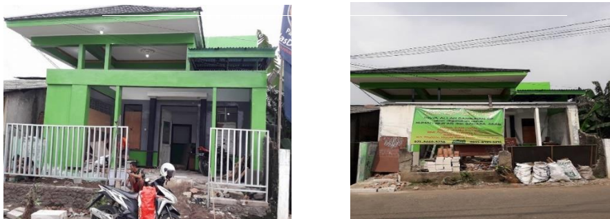
Gambar 3. 1 Bangunan rumah tahfidz
