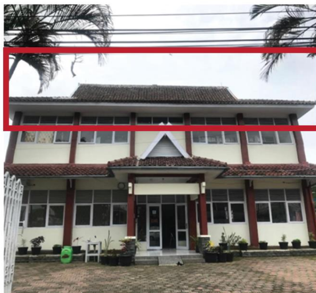
Gambar 32. Bangunan eksisting Perpustakaan Umum Kota Tasikmalaya
