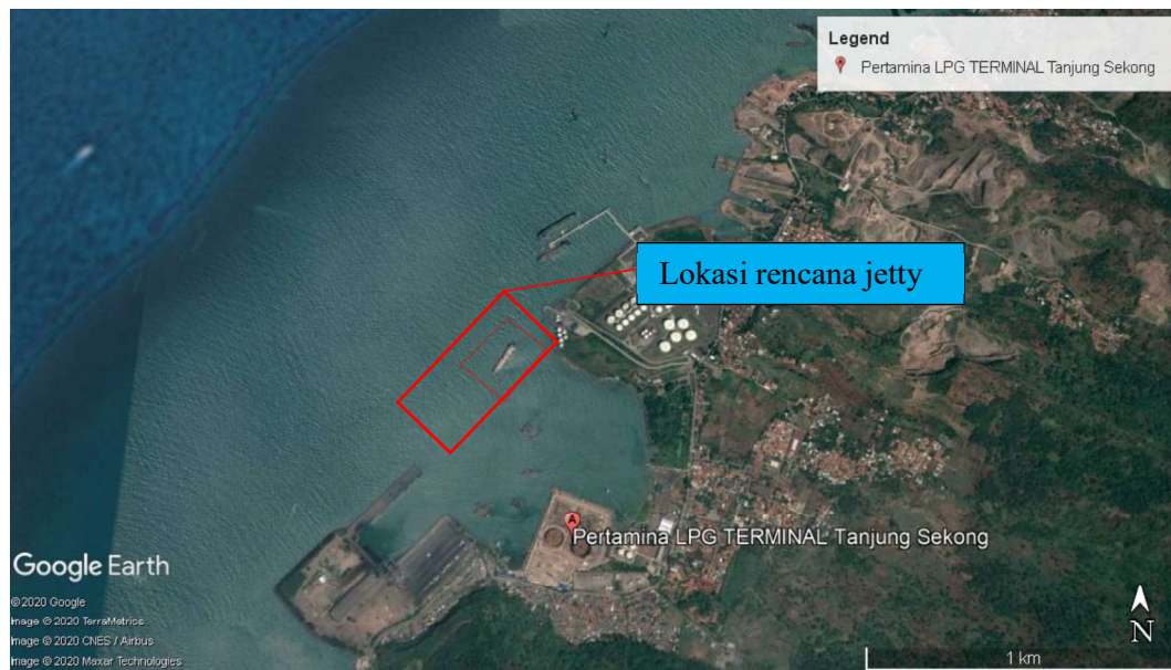
Gambar 3. 1. Lokasi pembangunan Jetty (Sumber: Google Earth )
