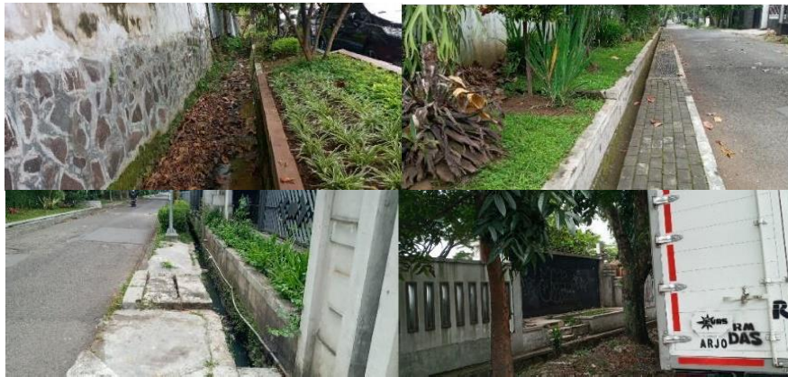
Gambar 3.16 Fasilitas Drainase Sumber: Dokumentasi Penulis
