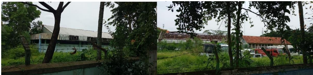
Gambar 3.4 Kondisi Fisik Aktual Tapak Sumber: Dokumentasi Penulis
