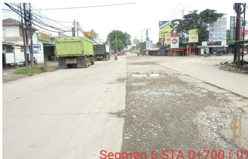
Gambar 3.3 Kondisi Eksisting Ruas Jalan Simpang Bitung-Curug
