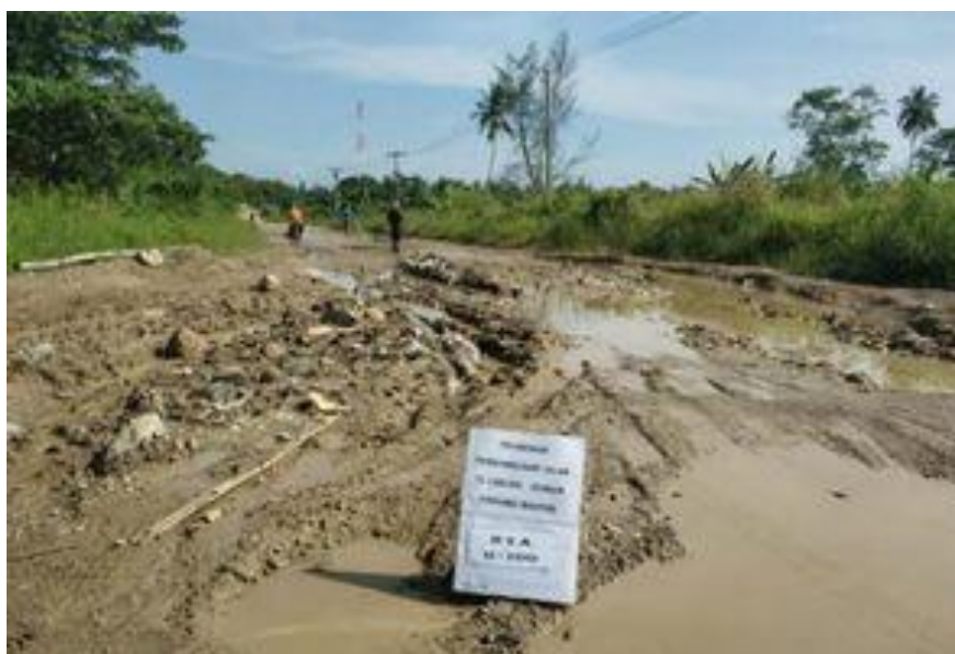
Gambar 3.4 Kondisi Eksisting Ruas Jalan Tanjung Lesung-Sumur
