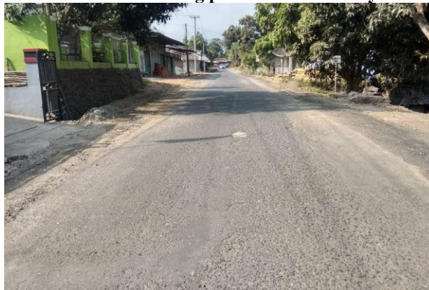
Gambar 3.3 Kondisi Existing pada Ruas Jalan Bayah-Cikotok
