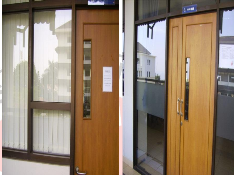
Gambar 3.7 Kondisi Kusen Pintu & Jendela
