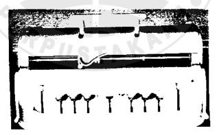
Mesin tik Braille atau pembraille yang gambarnya seperti di atas ini terdiri atas enam tut yang menghasilkan titik-titik Braille pembentuk huruf
