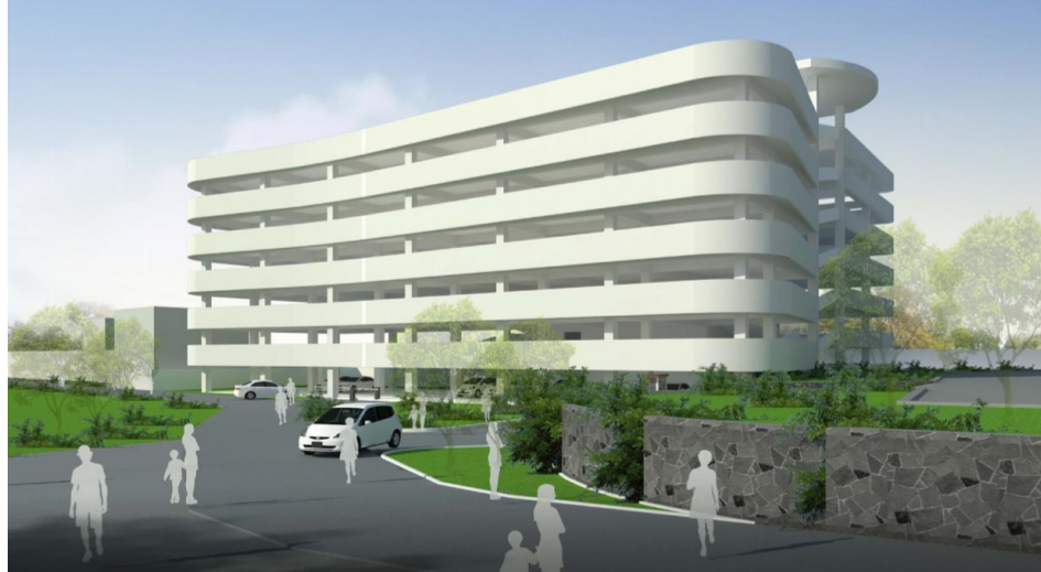
Gambar 3. 2 Lokasi Proyek Gedung Parkir Universitas Pendidikan Indonesia
