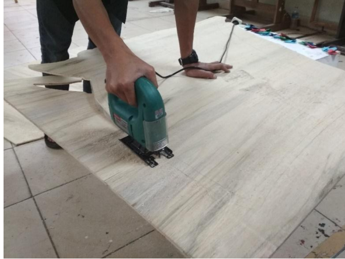
Gambar 3.28 Proses pemotongan multiplek (sumber dokumentasi pribadi)
