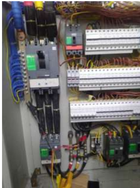
Gambar 3. 4 Proses Pengukuran Harmonisa pada SDP
