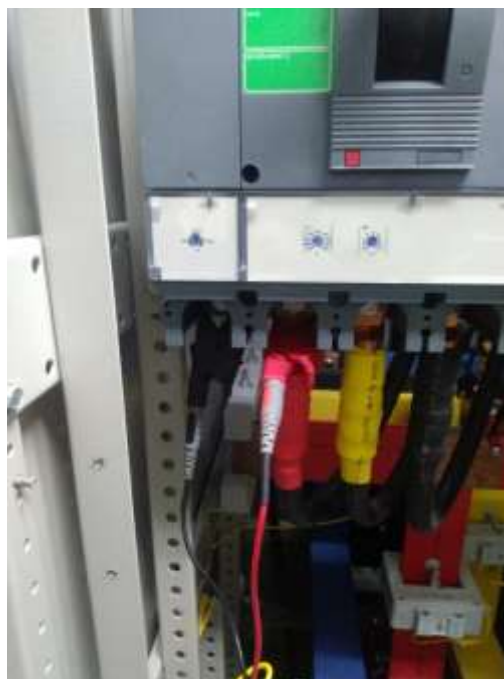
Gambar 3. 5 Proses Pengukuran Harmonisa pada MDP
