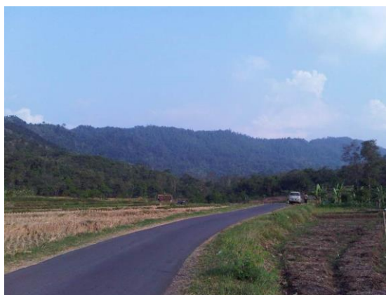
Gambar 4.6 Kondisi Jalan Sumber: Dokumentasi Pribadi, 2018
