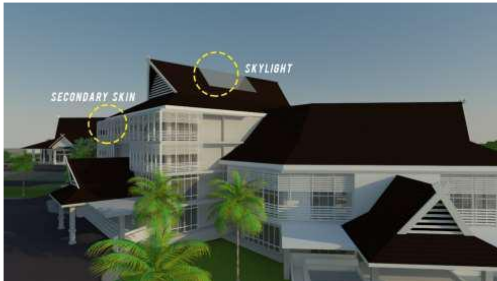
Gambar 5. 9 Penerapan Skylight dan Secondary Skin Sumber : Dokumentasi Pribadi, 2018
