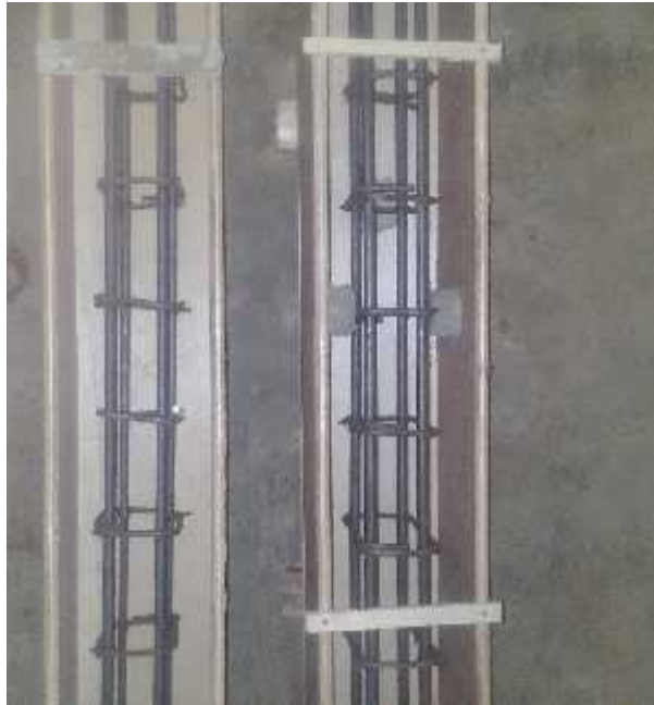
Gambar 3.13 Pembersihan di area bekisting
