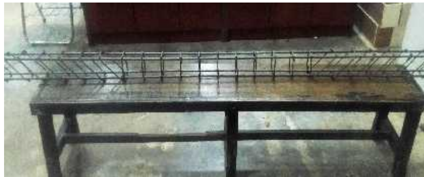
Gambar 3.9 Persiapan Tulangan sebelum dimasukkan ke bekisting
