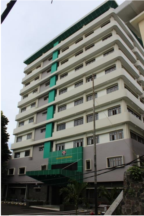
Gambar 3.70 Gambar Fasad FIP Sumber: Dokumen Pribadi, (2019)
