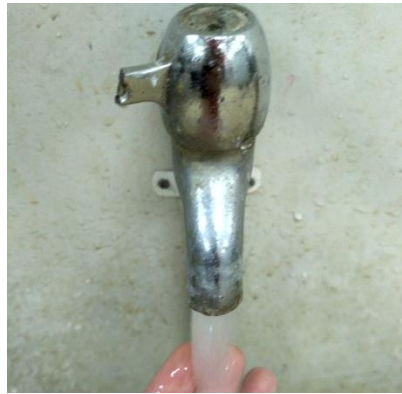
Gambar 3.15 Air pada Kran Di Laboratorium Hidrolika(Dokumentasi Pribadi)
