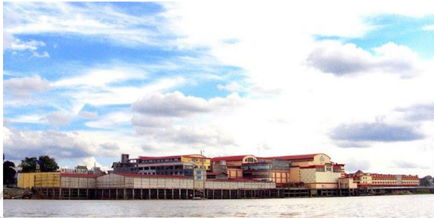
Gambar 3.3.Foto Mall WTC Batanghari (tampak belakang)
