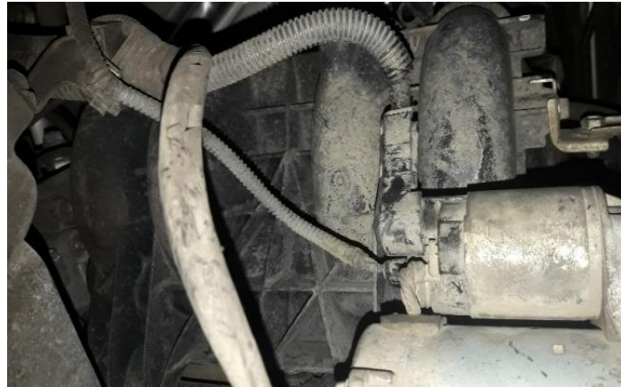
Gambar 3.3 Kabel menempel pada solenoid terminal 50 dan 30 (Sumber : Dokumentasi)
