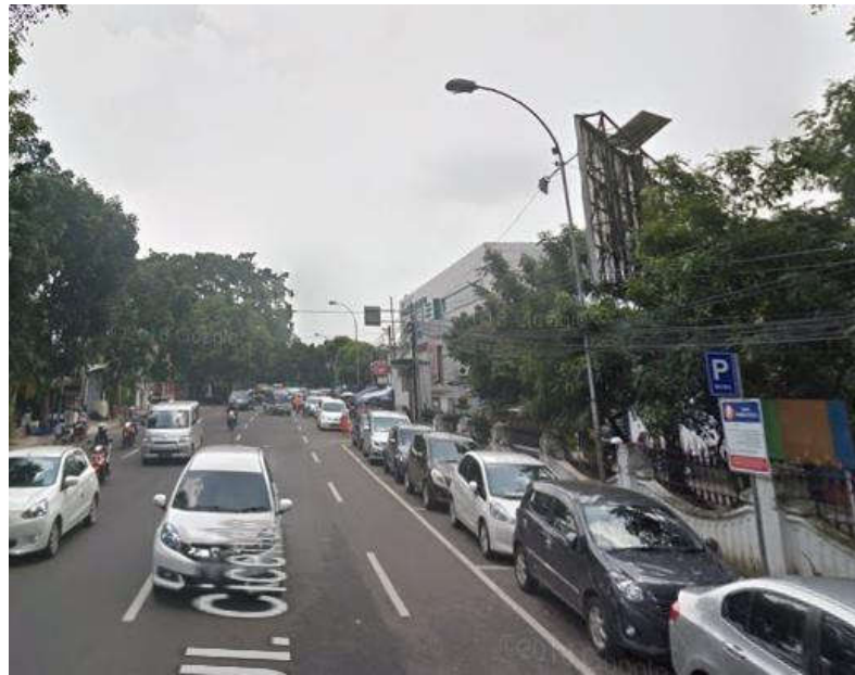
Gambar 3.3 Kondisi PJU di Jalan Cicendo (Google Maps, 2019)
