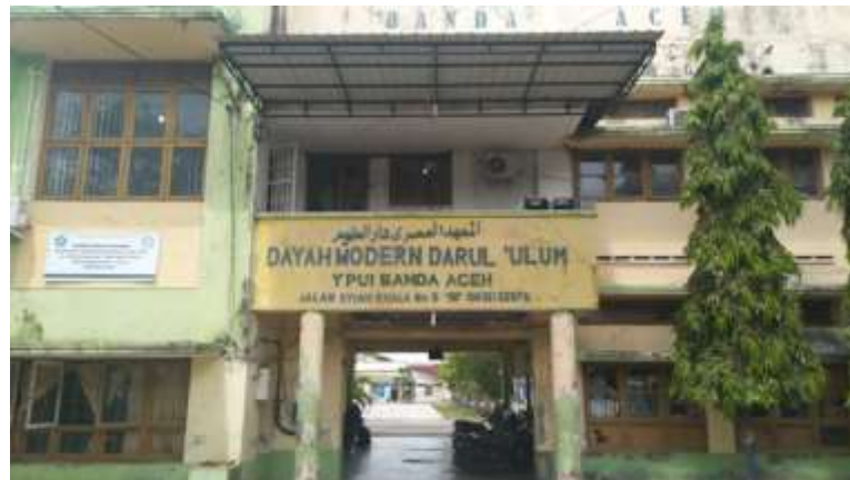
Gambar 5.1 (Gedung SMP Islam YPUI Banda Aceh) (Sumber Dokumentasi : Puspa Hildayani, 2018)
