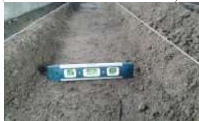
Gambar 3. 14 Pengecekan Kedataran Saluran
