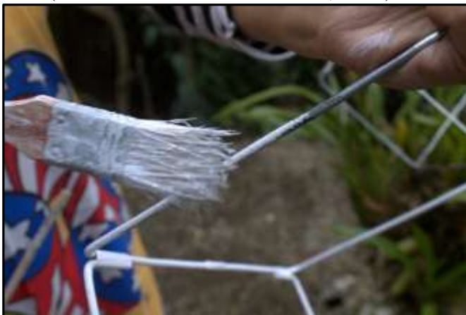
Gambar 3.23 Pengecatan Rangka Kawat Besi (Sumber: Dokumentasi Pribadi, 2016)
