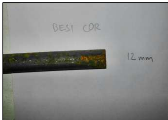
Gambar 3.10 Besi Beton (Sumber: Dokumentasi Pribadi, 2016)
