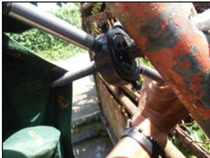
Gambar 3.26 Pembuatan Ulir pada Besi Beton (Sumber: Dokumentasi Pribadi, 2016)
