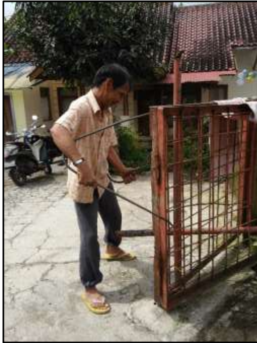
Gambar 3.25 Pembengkokkan Besi Beton (Sumber: Dokumentasi Pribadi, 2016)
