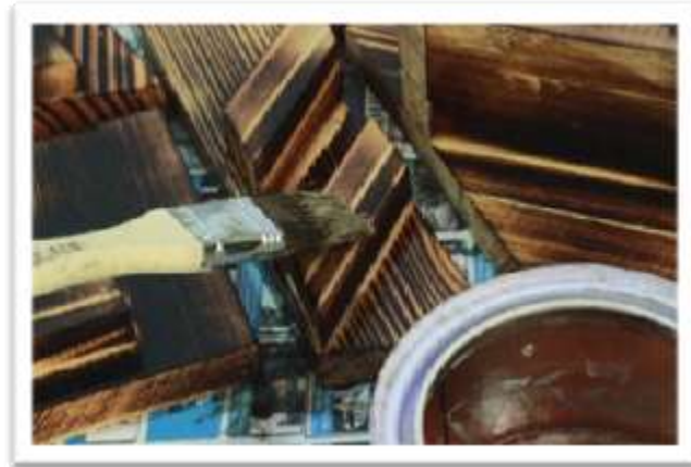
Gambar 3.37: Proses Pelapisan Pernis Sumber: Dokumentasi Pribadi, 2017
