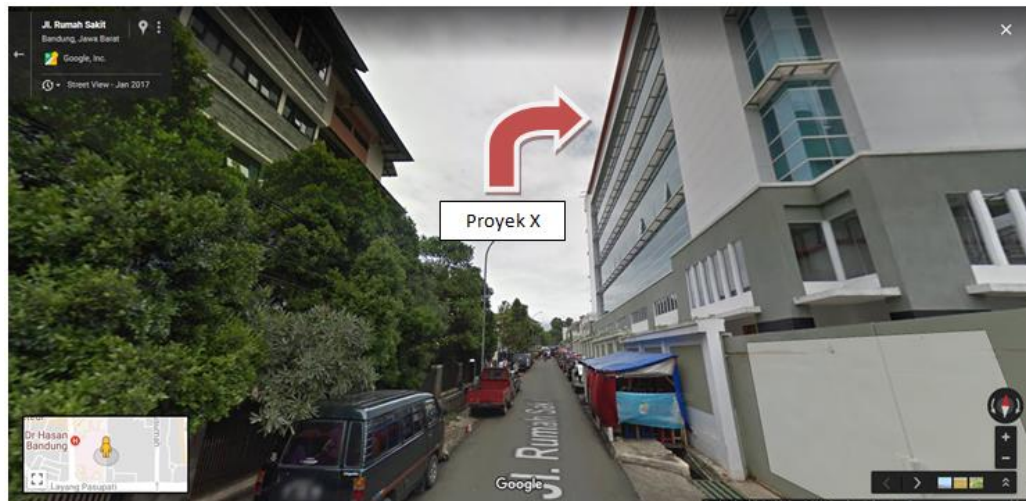
Gambar 3.2 Kondisi terbaru proyek X
