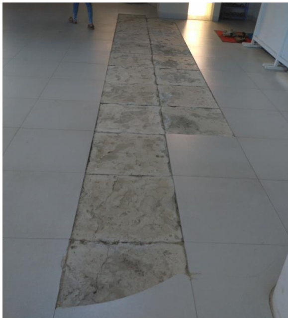
Gambar 3.3 Kerusakan Lantai pada lantai 4 (R.Pamer Tidak Tetap)
