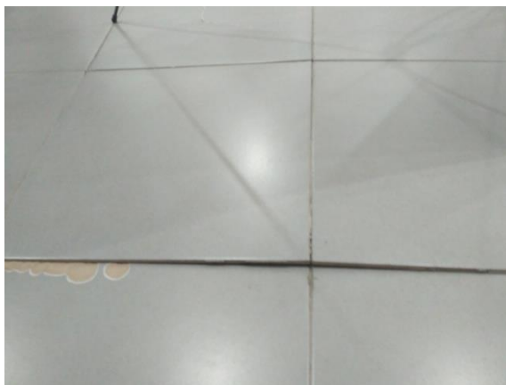
Gambar 3.3 Kerusakan Lantai pada lantai 4 (R.Pamer Tidak Tetap)
