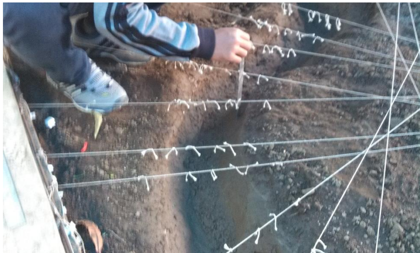
Gambar 3.13 pengukuran gerusan setelah pengaliran (Sumber : Dokumentasi Pribadi)
