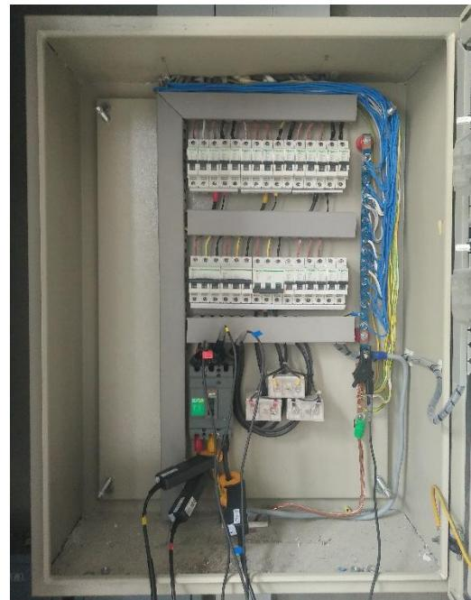
Gambar 3.7 Proses Pengukuran Harmonisa pada SDP
