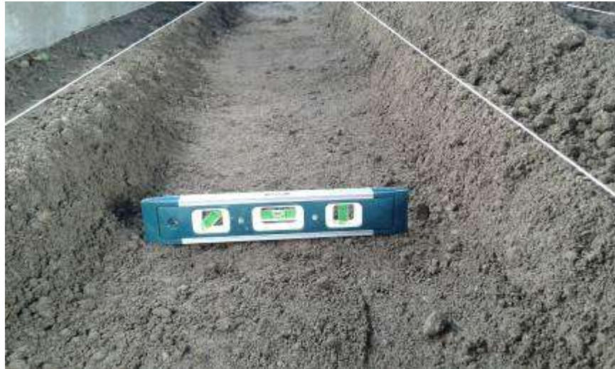
Gambar 3.8 Pengecekan kedataran saluran (Sumber : Dokumen Penelitian)
