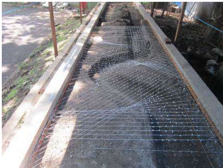
Gambar 3.9 Pemasngan benang grid pada saluran (Sumber : Dokumen Penelitian)
