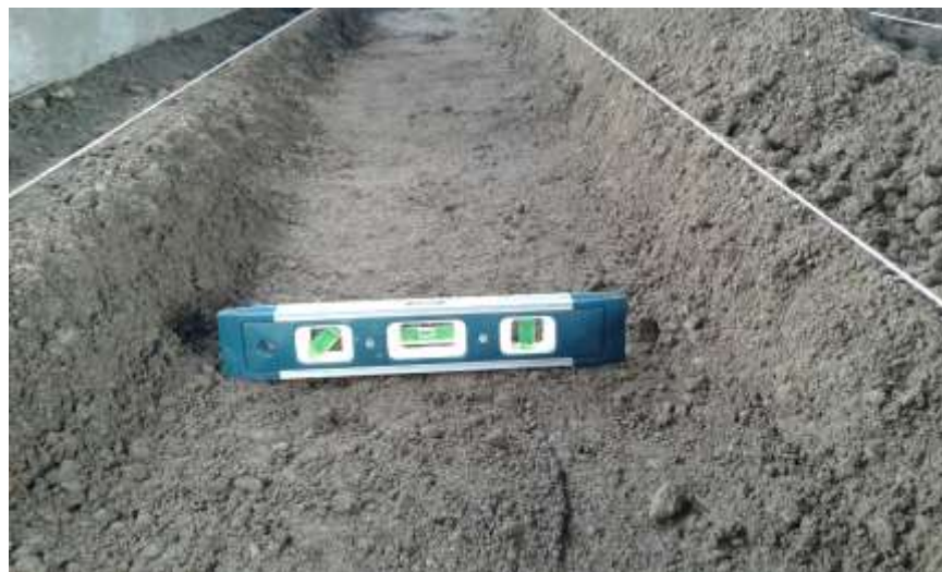
Gambar 1.16 Pengecekan kedataran saluran (Sumber : Dokumentasi Pribadi)
