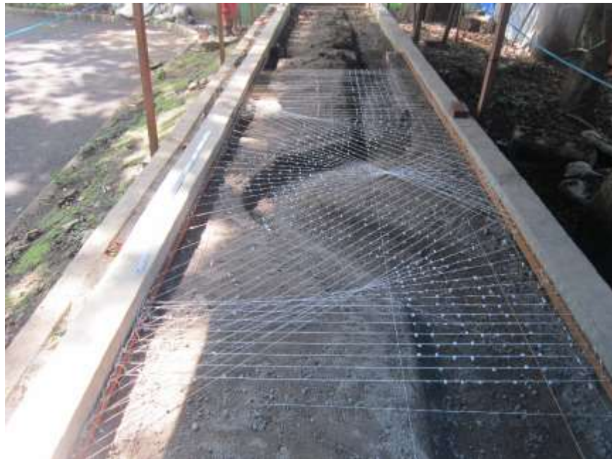
Gambar 1.17 Pemasangan benang grid pada saluran (Sumber : Dokumentasi Pribadi)
