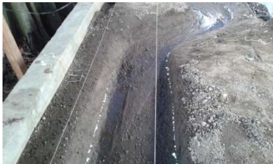
Gambar 1.30 Hasil situasi sungai setelah running
