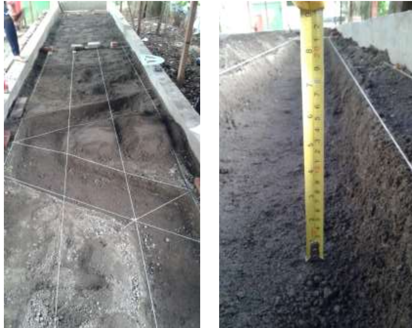
Gambar 1.15 Pembentukan alur sungai (Sumber : Dokumentasi Pribadi)
