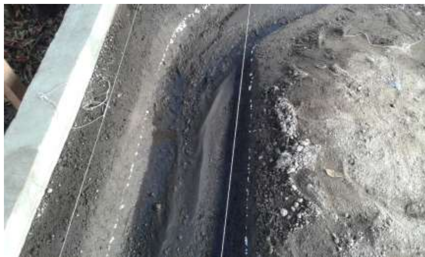
Gambar 1.42 Hasil situasi sungai setelah running
