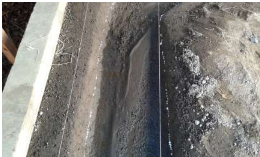
Gambar 1.36 Hasil situasi sungai setelah running
