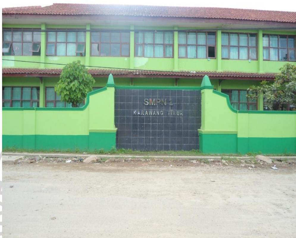
Gambar 3.2 (gedung SMPN 1 Karawang Timur Tampak Depan Dokumentasi Yudi Wahyu Widiana Maret 2013)
