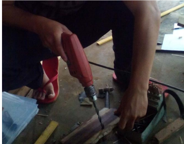
Gambar 3.45 Proses pengeboran Sumber: Dokumentasi pribadi
