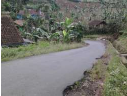
Kondisi jalan di Desa Pasirlangu
