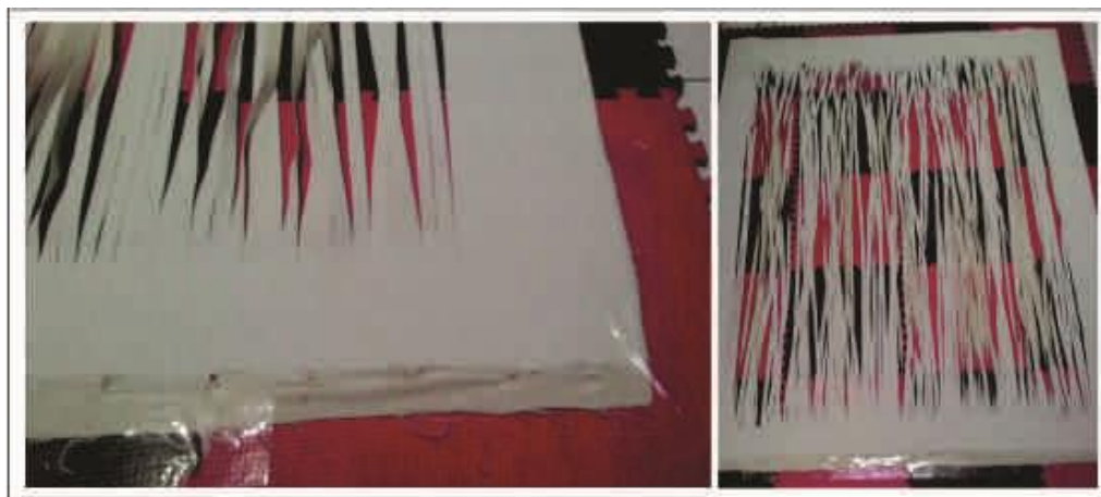
Gambar 3.36 Perekatan pada Lantai dengan Lakban (Sumber: dokumentasi penulis, 2015)
