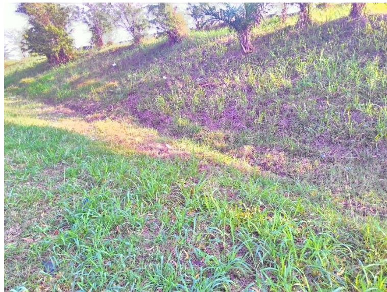
Gambar 1.2. Kondisi Saluran Samping Jalan Tol
